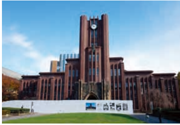
講堂の建つ場所は、思いのほか、小高い丘の上である。白いフェンスは改修工事のためのもの
