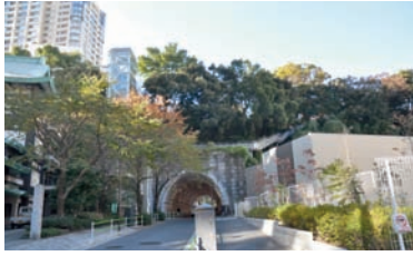
愛宕山の中央付近を貫くトンネルは1930年竣工。左に見えるガラス張りの塔屋は、麓と山頂を結ぶエレベーター
