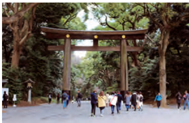
創建時から変わらない南参道にある一の鳥居
