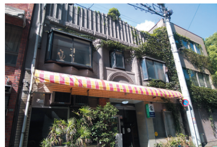
店は「看板建築」と称する建築様式で建てられている
