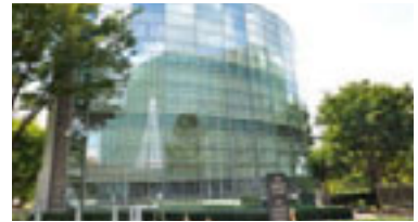
別館の前面は本館と同じ総ガラス張りだが……
